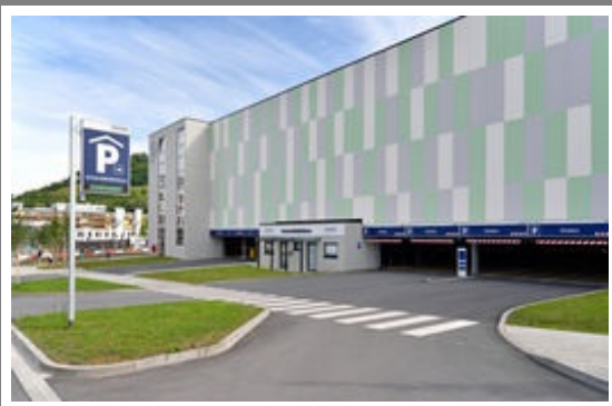
Thüringens größtes Parkhaus
